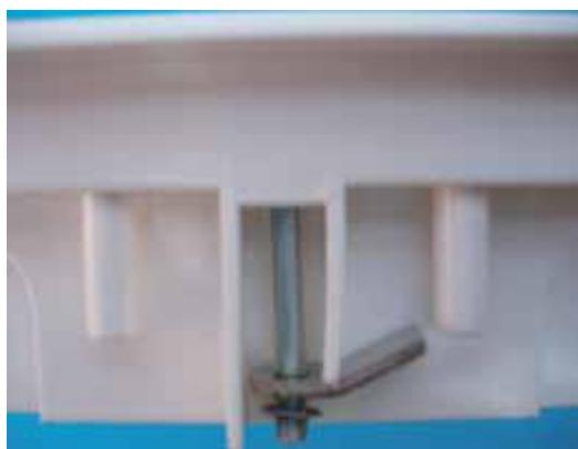
La cubeta dispone de 2 garras que sujetan con firmeza la caja a la mampara, con espesores comprendidos entre 12 y 50 mm. Además cuenta con una solapa para tapar el corte realizado en la mampara.
