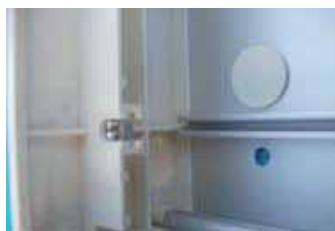
El cierre de la puerta se realiza mediante un tornillo que rosca sobre una tuerca metálica.
